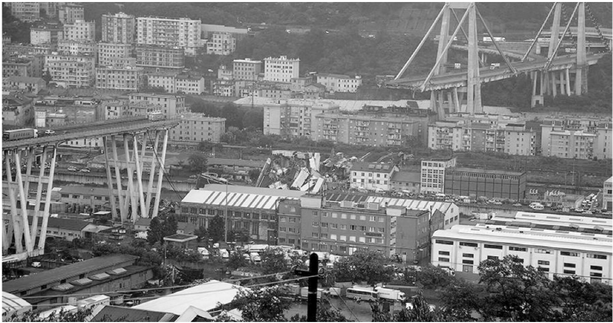
Рис.1. Обвал віадук в м.Генуя, Італія
