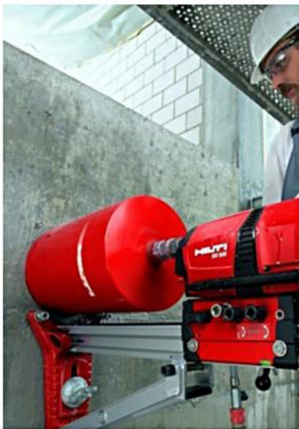
Рис. 4 Фотофрагмент процесса вырезания образца в кирпичной стене жилого здания
