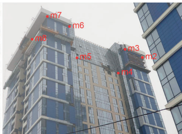
Рис. 9 Схема закріплення марок спостереження на фасаді пошкодженого Блоку 2 житлового комплексу
