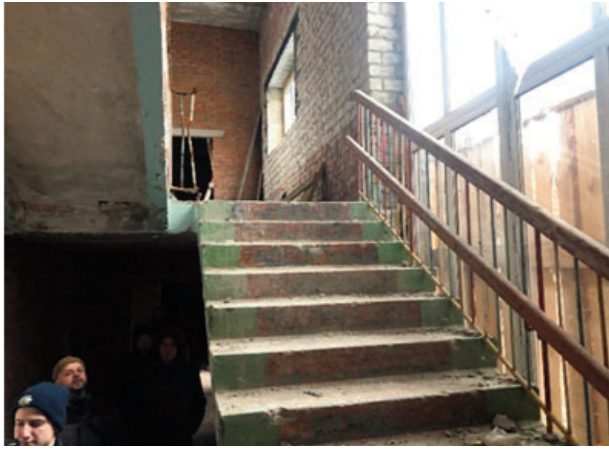
Рис 4. Обладнання сходів поручнями для дітей та дорослих
