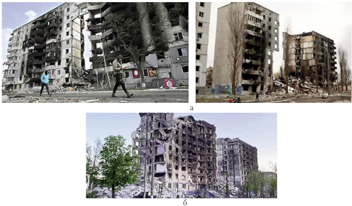
Рис. 1.8 Зруйновані панельні будинки за 2-м випадком (пряме влучання): а) – с. Бородянка, Київська область; б) – в Луганській області
