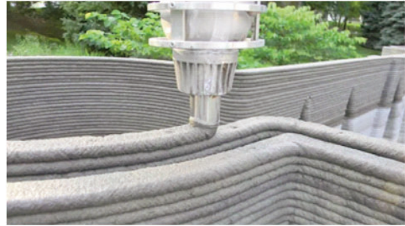
Рис. 1 Будівельний 3D-друк за допомогою бетонної суміші
