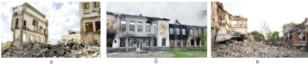
Рис. 1.3 Зруйновані за другим випадком (при прямому влучанні): а) – будинок в Харківській області; б) – влучанням та пожежею школа №1 в м. Авдіївка, Донецька область; в) – будівля в Миколаївській області
