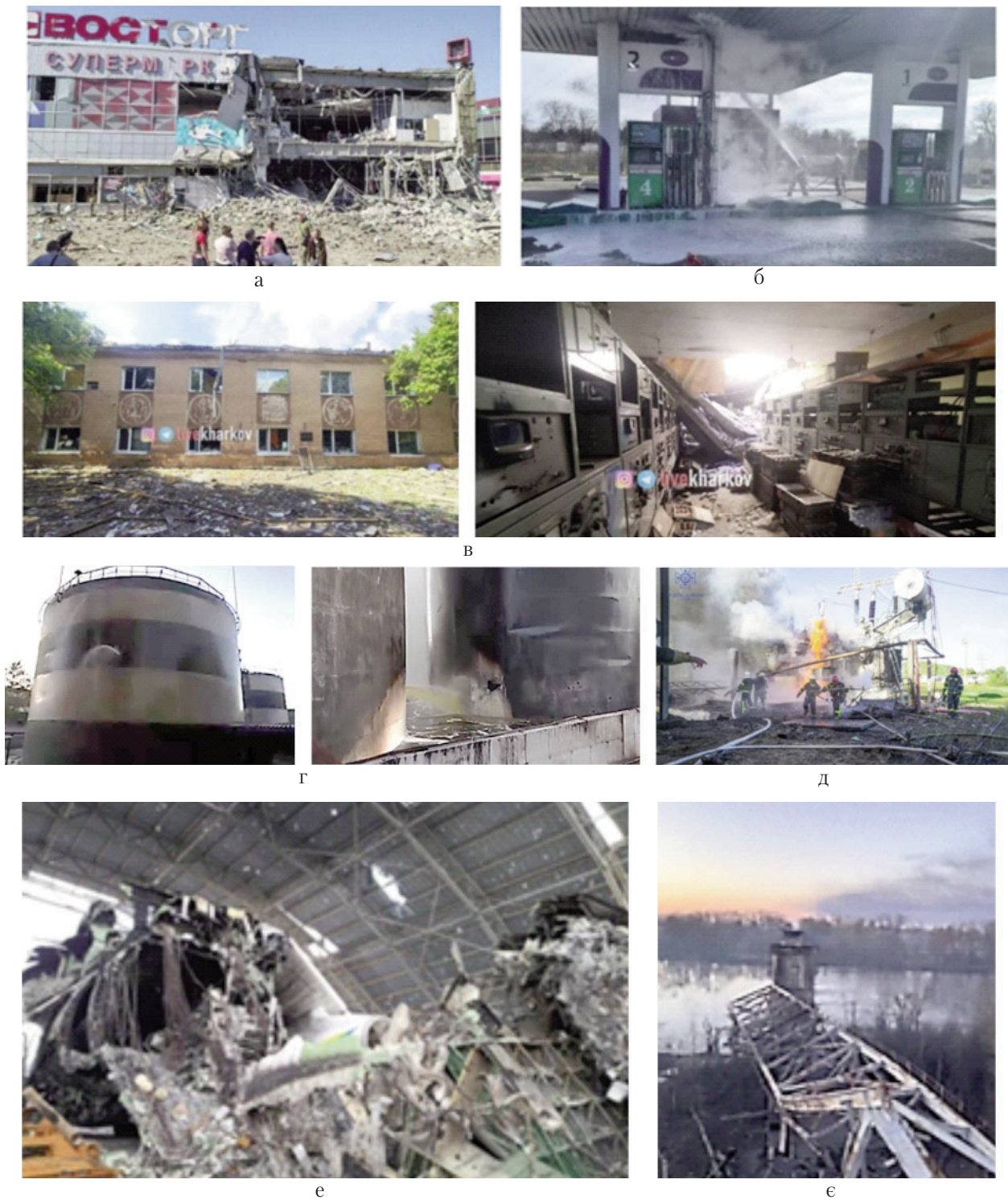
Рис. 1.10 Пошкоджені: а) – прямим влучання супермаркет з металевим каркасом у м. Харків; б) – автозаправна станція у м. Миколаїв; в) – Радіоастрономічна обсерваторія імені Семена Брауде у селі Волохів Яр, Харківська область; г) – сталеві резервуари з олією у Миколаєві (червоним кольором позначені місця отворів, які були пробиті осколками); д) – електрична підстанція у м. Київ; е) – ангар аеропорту в селищі міського типу Гостомелі, Київська область; є) – міст у Чернігівській області
