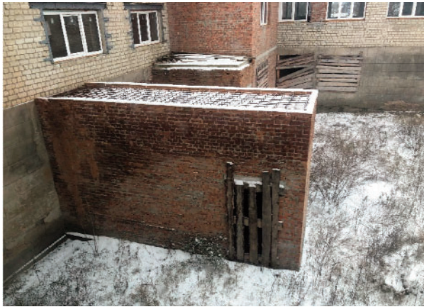
Рис 6. Влаштування додаткового виходу назовні з підвалу
