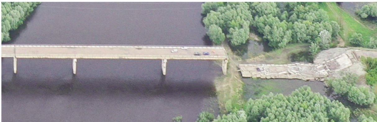
Рис. 1. Загальний вид моста після руйнування прогонів між опорами 7÷11 (аерофотозйомка)
