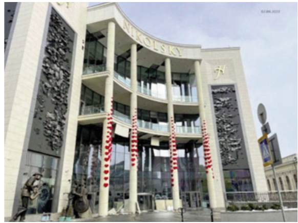
Рис. 1. Головний фасад будівлі торгівельно-розважального центру після перших обстрілів 02.03.2022
