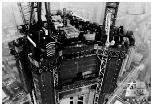
Рис. 4 Піднімання МТМК по зовнішнім стінам при зведенні монолітного каркасу будівлі
