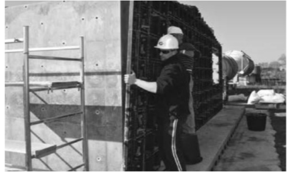
Рис. 4. Використання опалубки GeoPlast для укладання монолітного пінобетону при влаштуванні огорожувальних конструкцій житлової будівлі в м. Знамянка
