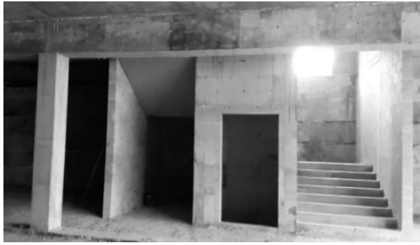
Рис. 3. Приклад використання монолітного пінобетону в якості внутрішніх стін торговельного комплексу в м. Кропивницький
