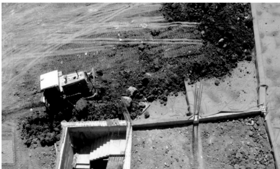
Рис. 1. Зворотна засипка виконаної гідроізоляції ґрунтом з включенням каменів
