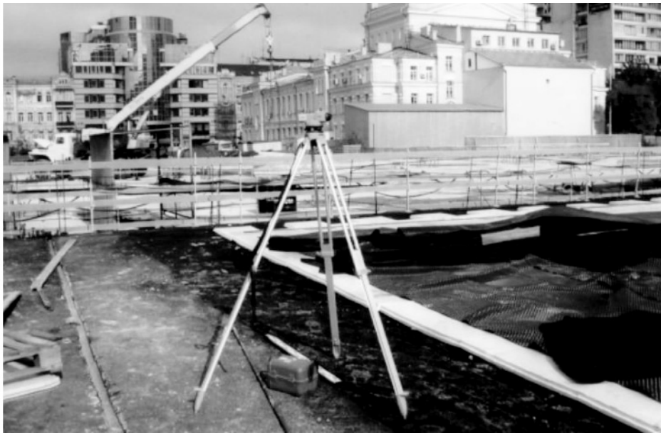
Рис. 3. Встановлення нівеліра на виконаній гідроізоляції
