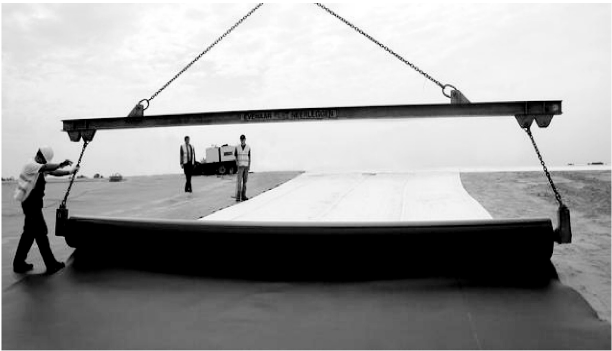
Рис. 4. Влаштування гідроізоляції із полімерної геомембрани
