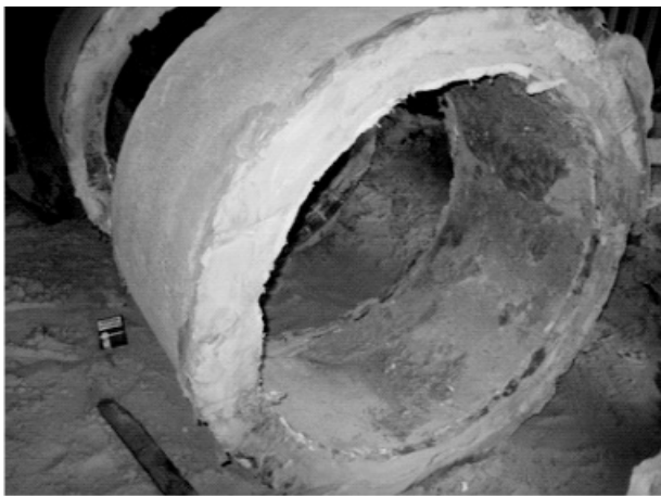
Рис. 12. Загальний вид стику після розрізу, загерметизованого за шостою технологією
