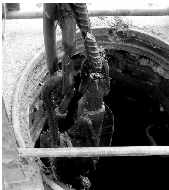
Рис. 4. Прочистка засоренной корневыми тканями дренажной трубы
