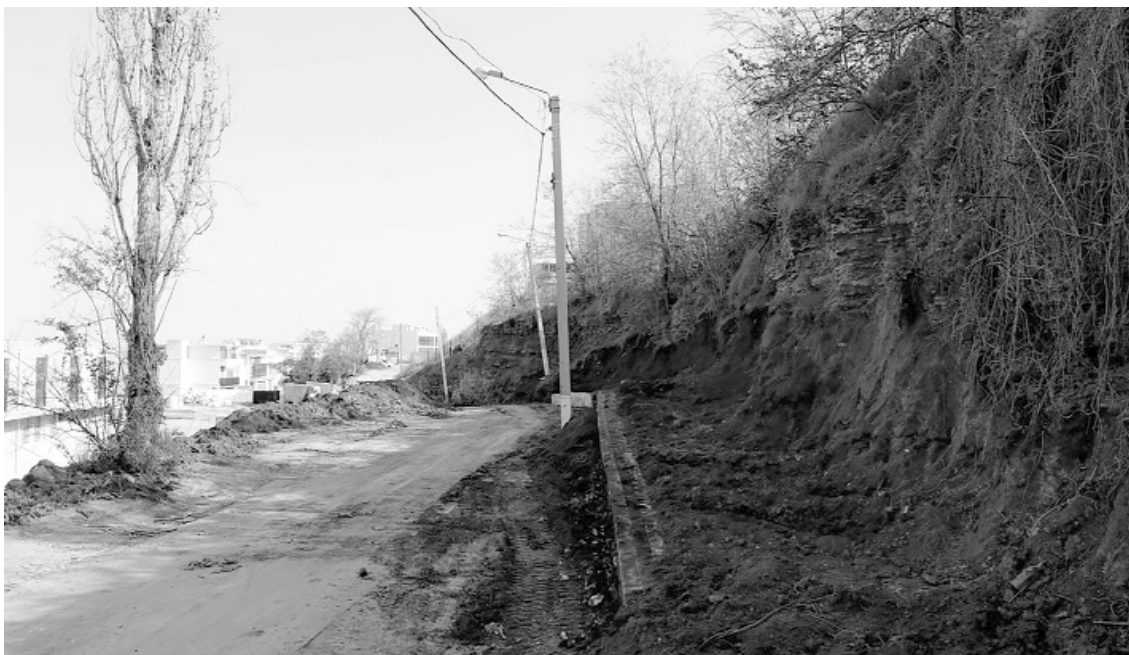
Рис. 1 Підрізання схилу під будівництвом комплексу "Морська симфонія"
