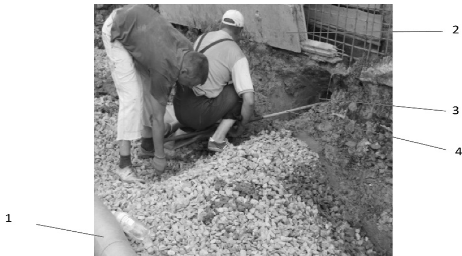
Рис. 7. — Утворення свердловини за допомогою ручного буру з подовжувачем 1 — патрубок обгорнутий геотекстилем; 2 — облицювання стіни; 3 — свердловина; 4 — ручний бур
