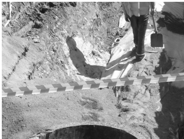
Рис. 3. Попадание ненормируемых материалов в грунт обратной засыпки
