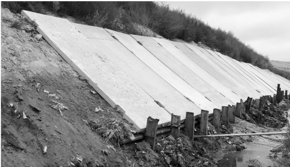
Рис. 4. Приклад влаштування стримувальної протизсувної споруди на полігоні ТПВ №5 в Підгірці Обухівського району Київської області 2018 рік
