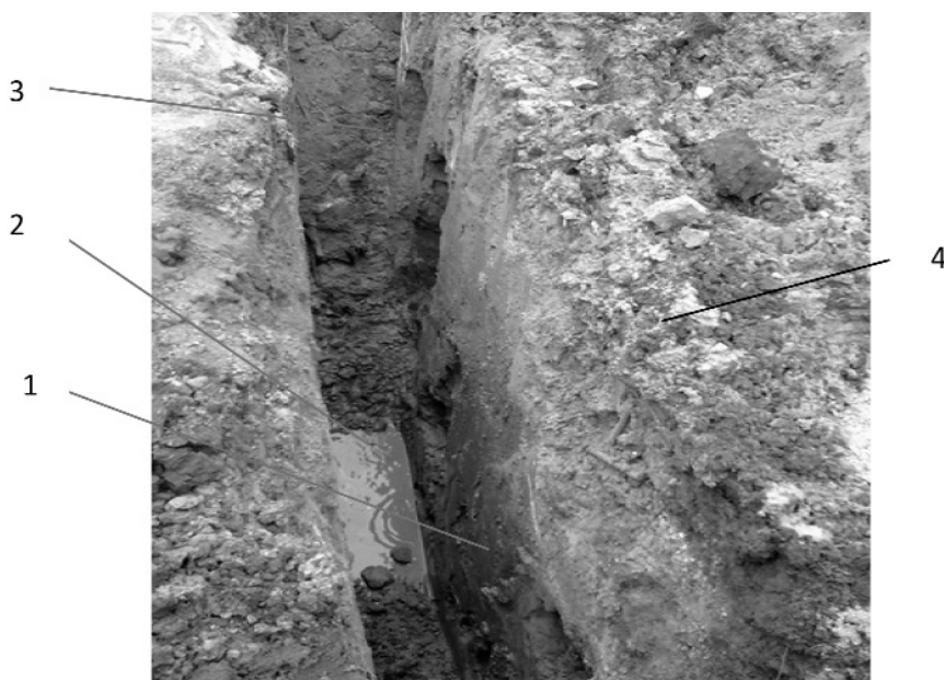
Рис. 6. Видгляд траншеї перед вкладанням габіонів. 1 – траншея; 2 – залишки ґрунтової води; 3 –забій екскаватора; 4 – залишки насипу ґрунту над палами
