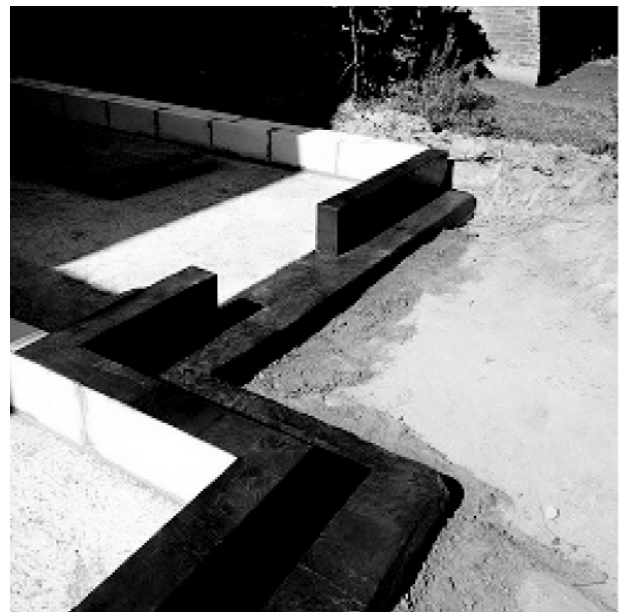
Рис. 6. Гідроізоляція з високоефективної гнучкої еластомірної бітумної мембрани SBS з нетканим поліефірним армуванням фірми Soprema UK
