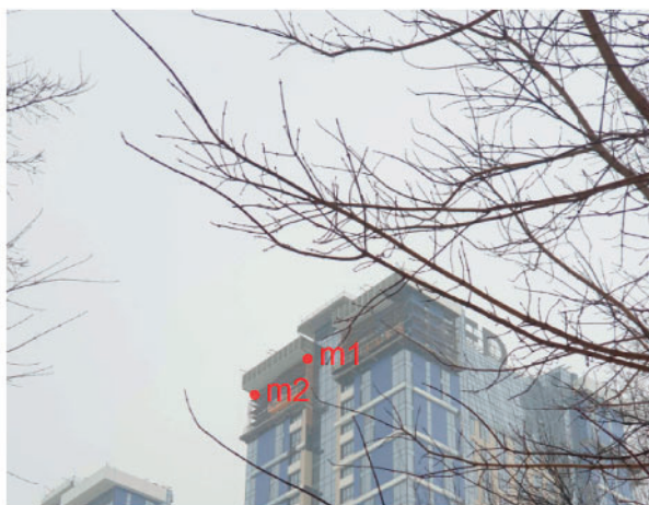
Рис. 9 Схема закріплення марок спостереження на фасаді пошкодженого Блоку 2 житлового комплексу
