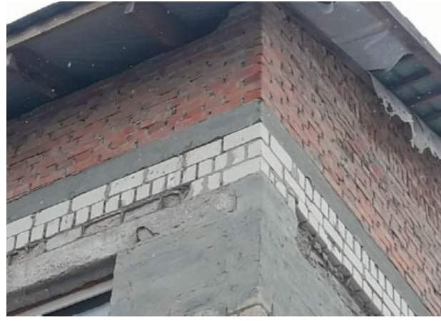
Рис 5. Збільшення висоти приміщень за рахунок монолітного з/б поясу та цегляної кладки (в момент реконструкції 2020-2021 рр).
