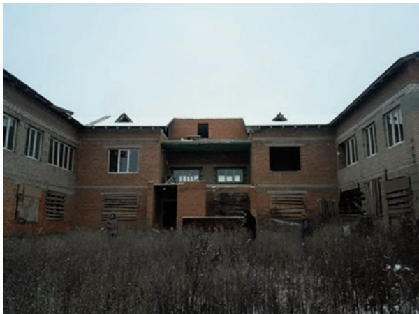
Рис. 1. Фрагмент головного фасаду (в момент реконструкції 2020-2021 рр.)
