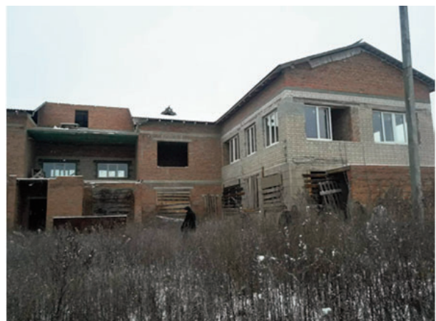
Рис. 2. Фрагмент головного фасаду (праве крило) (в момент реконструкції 2020-2021 рр.)
