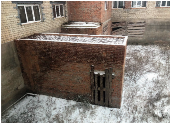
Рис 6. Влаштування додаткового виходу назовні з підвалу
