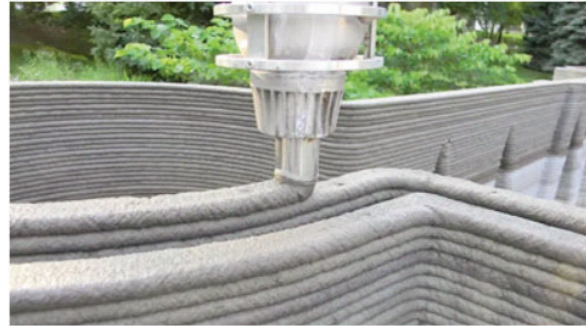
Рис. 1 Будівельний 3D-друк за допомогою бетонної суміші
