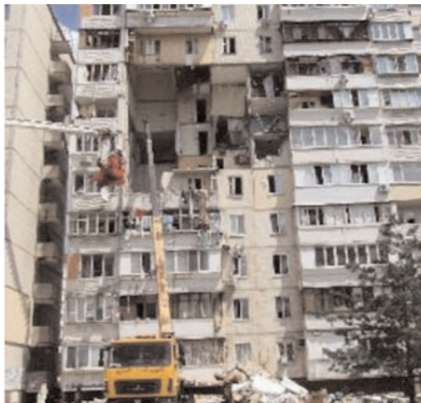
Рис. 1 – Головний та дворовий фасади пошкодженої секції будівлі з вул. Соломії Крушельницької, 1/5
