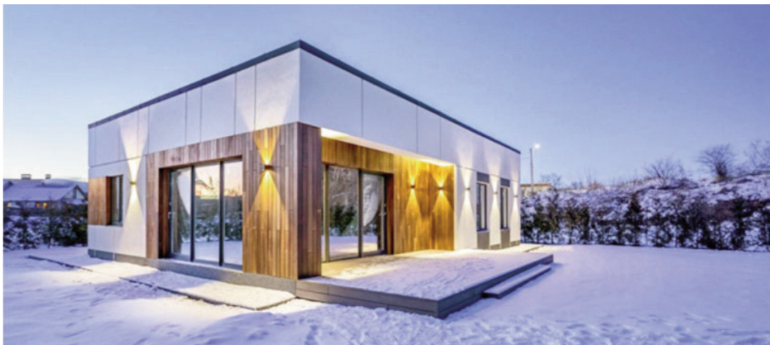
Рис. 4. Загальний вигляд збірно-монолітного будинку у с. Флоринка, м. Харків
