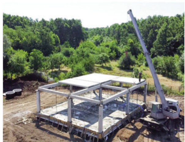
Рис. 2. Деякі технологічні рішення збірно-монолітної технології
