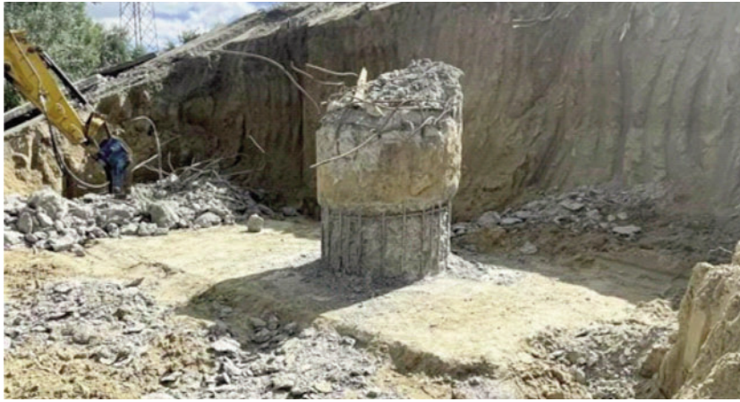
Рис. 3. Розбирання зруйнованих конструкцій
