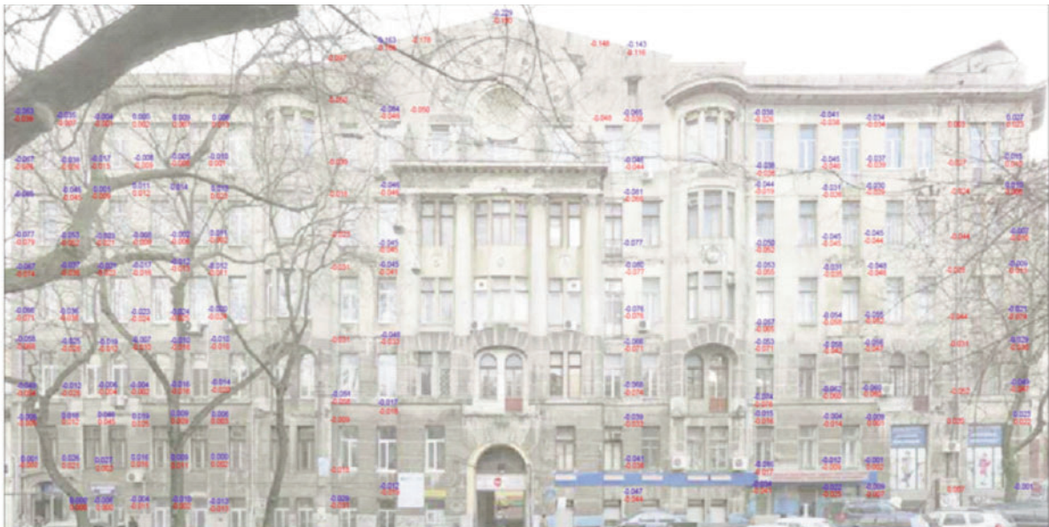
Рис. 7. Визначення крену будинку К. Асвадурова по вул. Троїцька, 25
