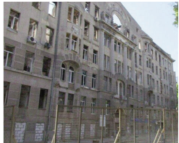
Рис. 4. Аварійний стан будинку К.Асвадурава після пожежі
