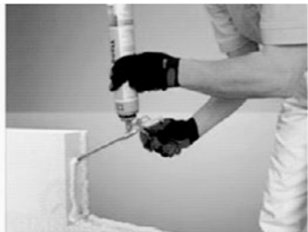
Рис. 5. Безшовна кладка газобетонних стін з використанням пінополіуретанової піни
