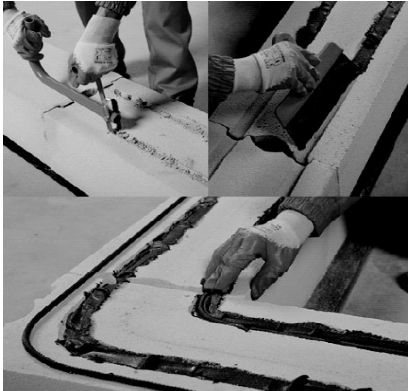
Рис.6. Прорізання штроб та укладка арматури
