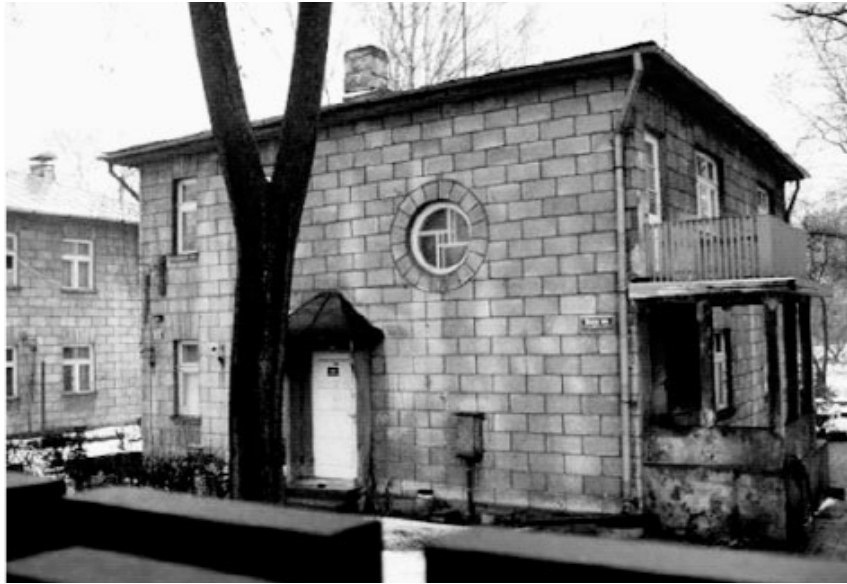
Рис. 2. Зовнішній вигляд будинку з автоклавного газобетону без оздоблювального шару побудований в 1939 році, м. Рига
