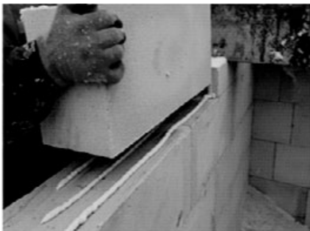
Рис. 5. Безшовна кладка газобетонних стін з використанням пінополіуретанової піни
