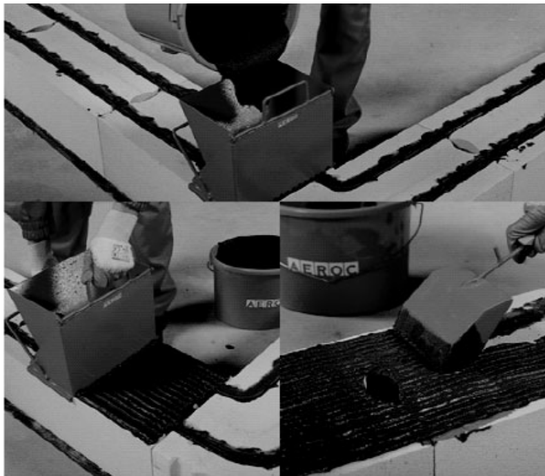
Рис. 4. Мурування блоків з використанням клею за допомогою каретки та зубчастого шпателя
