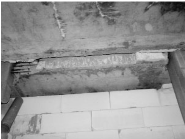
Рис. 2. Фотофіксація тріщин плити на позначці +69.3м
