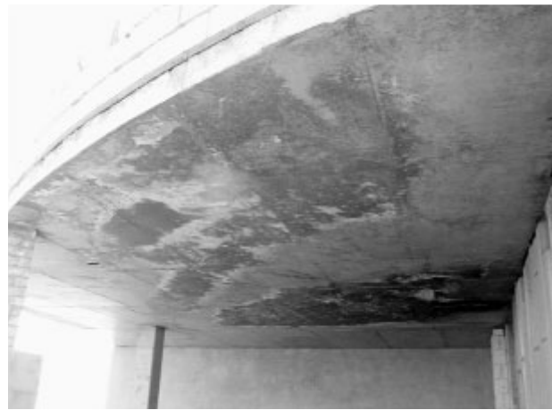
Рис. 2. Фотофіксація тріщин плити на позначці +69.3м
