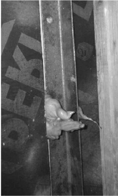
Рис. 6. Вигляд стику №7 нижня частина якого заповнена ущільнювачем поліуретановий Ø 20 з притисканням металевго кутика на підпорці
