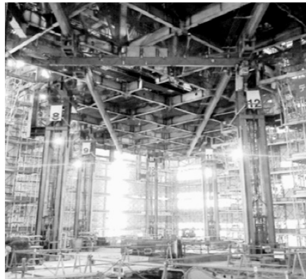
Рис. 3 Використання МТМК (Taisei Corporation) при демонтажі з використанням для вертикального переміщення опори, які розміщені в середині будівлі.[7]
