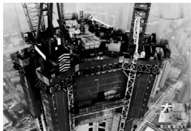
Рис. 4 Піднімання МТМК по зовнішнім стінам при зведенні монолітного каркасу будівлі
