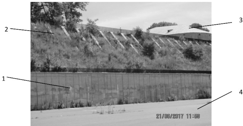
Рис. 1. Загальний вигляд палевої підпірної стіни ПС-5, що виконана поперек схилу 1 – палева підпірна стіна ПС-5, 2 – балки, що утримують круті відкоси за палевою стінкою, 3 – Косий капонір, 4 – покриття майдану зони гостинності
