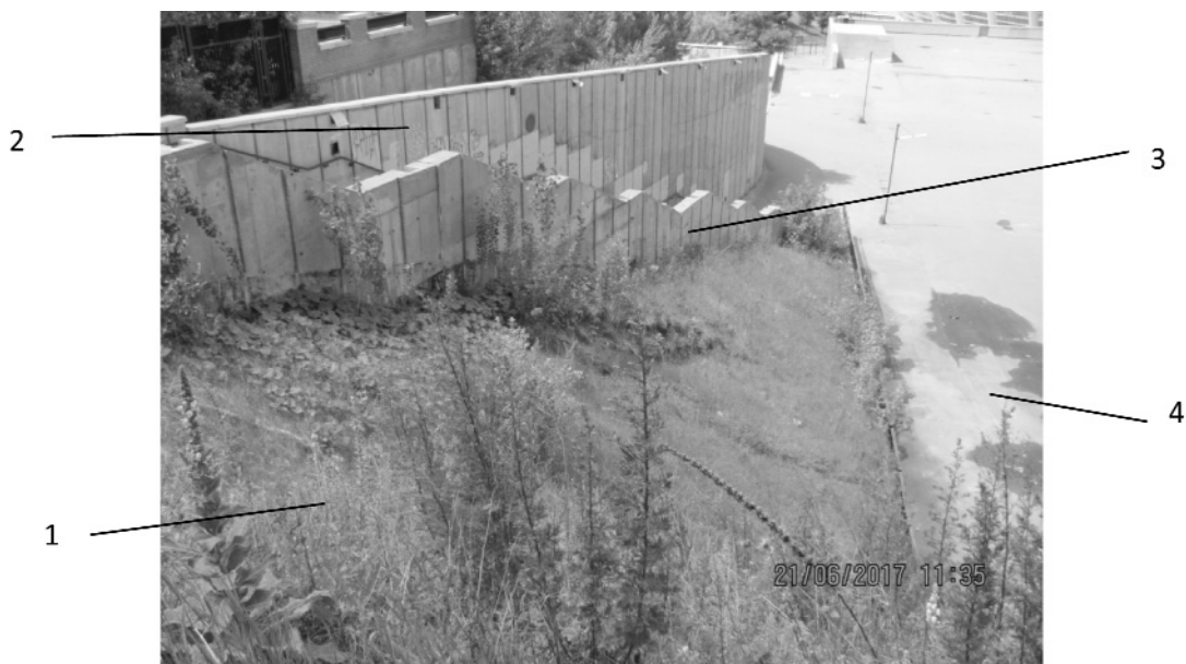
Рис. 2. Палеві підпірні стіни ПС-10 та ПС-11, що влштовані вздовж схилу 1 – крутий схил, 2 – палеві підпірні стіни ПС-10 та ПС-11, 3 – парпет з зовнішнього боку дробини, 4 – покриття майдану зони гостинності
