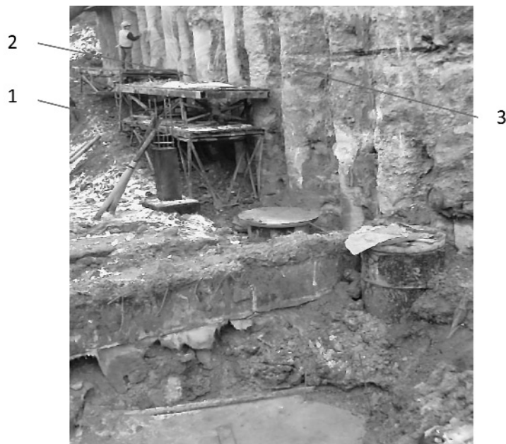
Рис. 8. Променеві дрени перед монтажем в палеву підпірну стіну ПС-10 1 — променева дрена в зборі; 2 — риштування; 3 — зовнішній ряд паль
