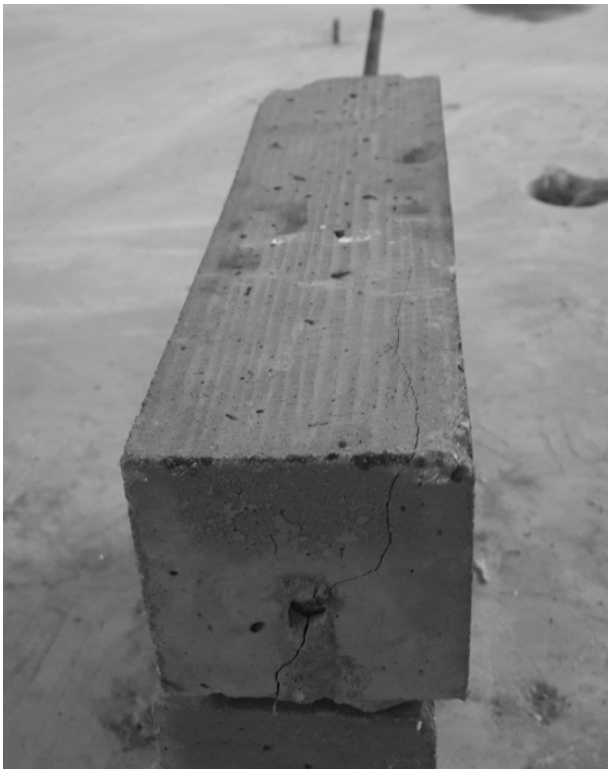
Фото 4. Дослідний зразок з ребристою арматурою після випробування
