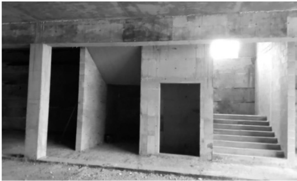
Рис. 3. Приклад використання монолітного пінобетону в якості внутрішніх стін торговельного комплексу в м. Кропивницький
