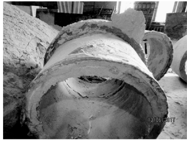
Рис. 6. Загальний вид стику після розрізу, загерметизованого за третьою технологією
