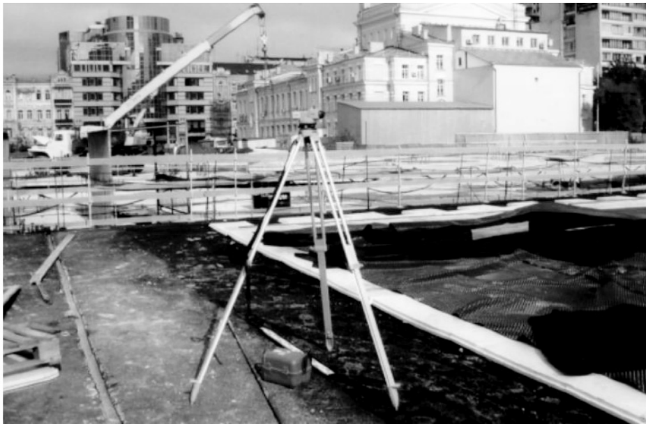
Рис. 3. Встановлення нівеліра на виконаній гідроізоляції
