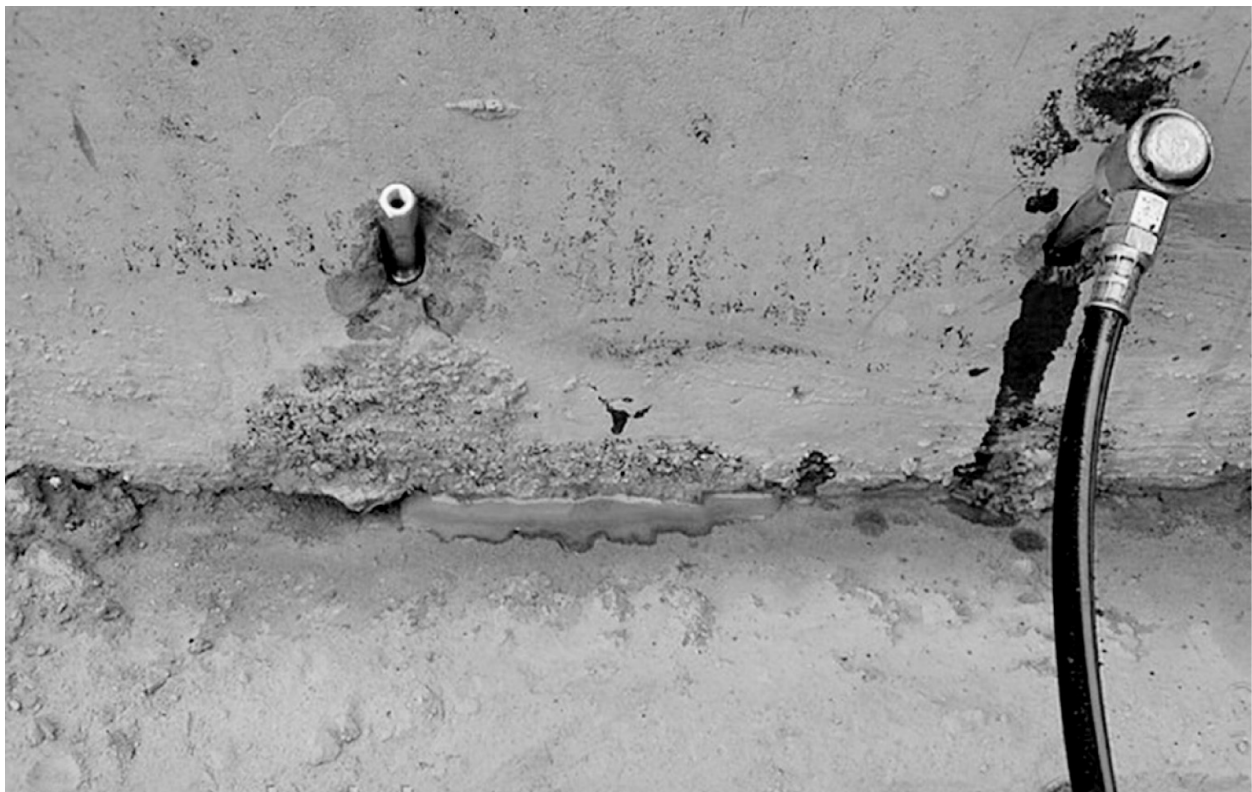
Рис. 3. Ін'єкційна гідроізоляція швів з матеріалу Мінова (Німеччина)
