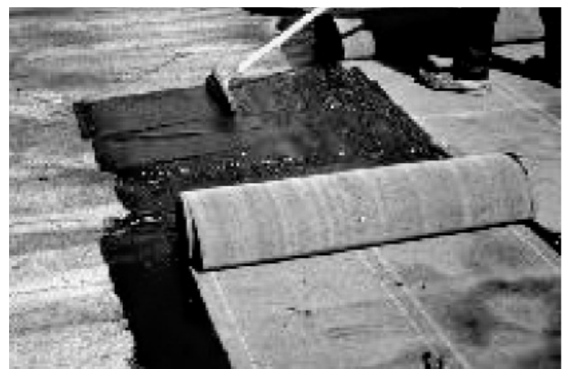
Рис. 1. Влаштування прогумованої мембрани ММ6125 на гарячий асфальтовий шар
