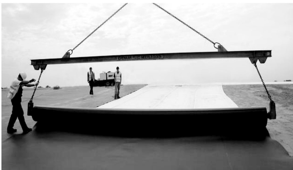
Рис. 4. Влаштування гідроізоляції із полімерної геомембрани
