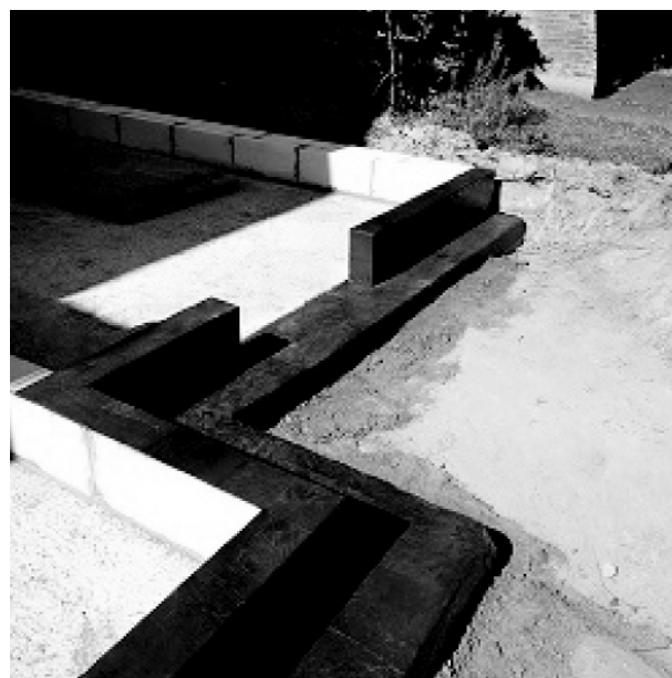
Рис. 6. Гідроізоляція з вискоєфективної гнучкої еластомірної бітумної мембрани SBS з нетканим поліефірним армуванням фірми Soprema UK
