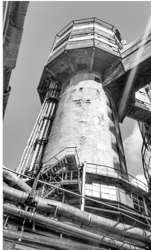
Рис.1. Вид на стовбур башти з північно-західної сторони
