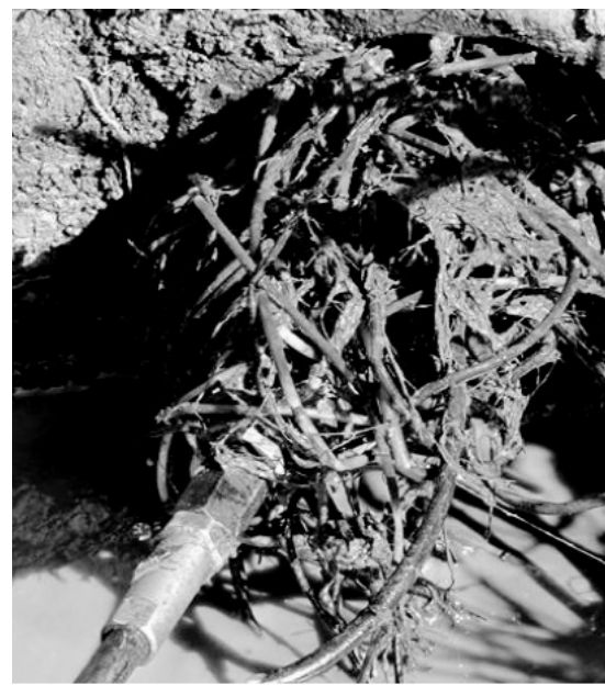
Рис. 4. Прочистка засоренной корневыми тканями дренажной трубы
