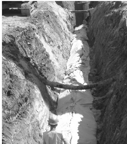
Рис. 2. Технологические нарушения при формировании щебеночной фильтрующей обсыпки с обертыванием геотекстилем
