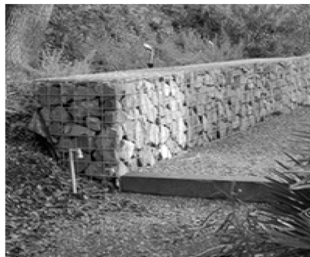
Рис. 11. Фото-фрагменти виготовлення габіонів
